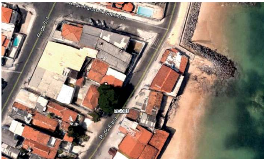
Figura 9: Remanescente da antiga casa do faroleiro, propriedade federal desabitada e em arruinamento, indicada pela seta branca
