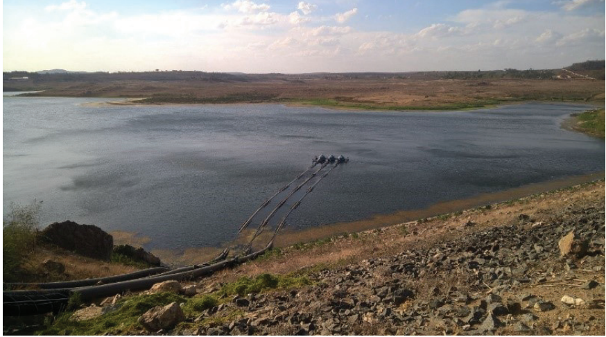
Figure 12 – Epitácio Pessoa Dam – Queimadas, PB.
