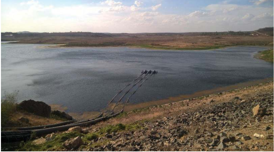
Figure 12 – Epitácio Pessoa Dam – Queimadas, PB.
