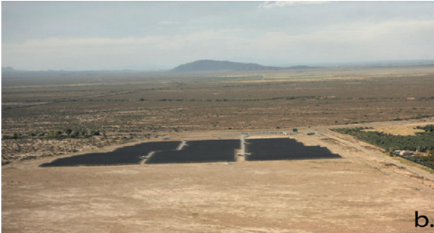
Imagen 1b – Central fotovoltaica Cañada Honda (San Juan).
