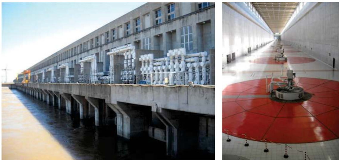
Fotos N° 3 y N° 4 Casa de máquinas (2010)
