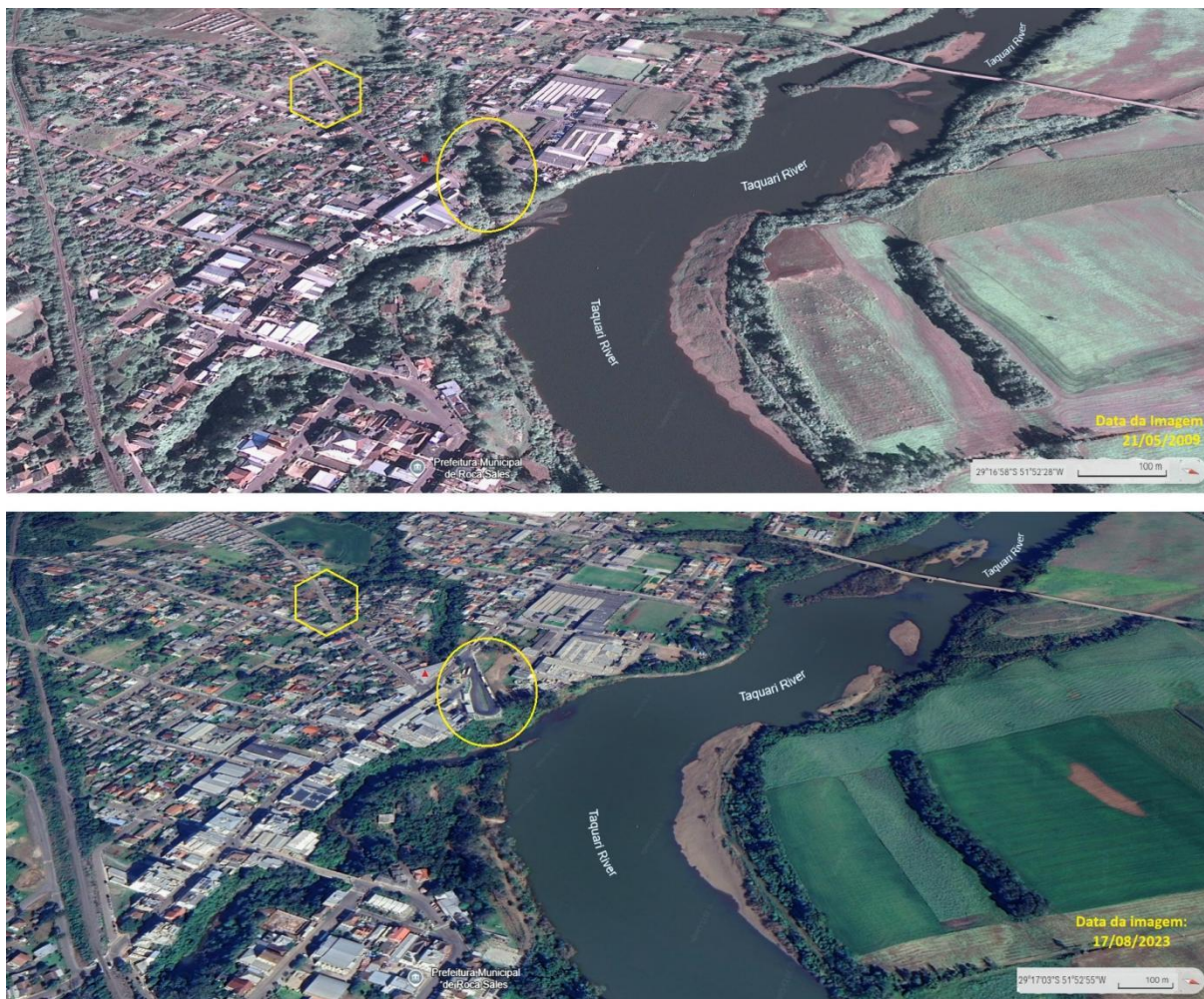
Figura 5: Aterro realizado em afluente do Rio Taquari (círculo) e área destruída pelo evento hidrológico extremo de 2023 e 2024 em Roca Sales (destaca pelo hexágono)
