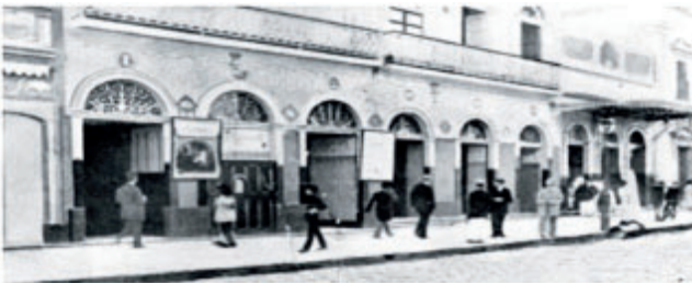
Figura 1: Cinema Pathé, inaugurado em 1909, na Rua Nova
