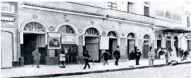
Figura 1: Cinema Pathé, inaugurado em 1909, na Rua Nova
