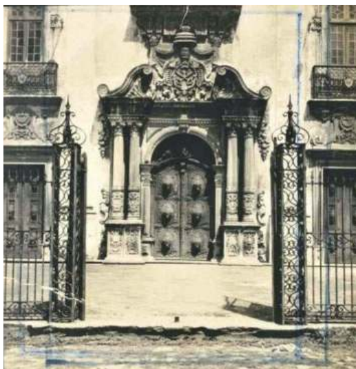
Figura 5: Fotografia da porta da Igreja de São Pedro dos Clérigos na década de 1930
