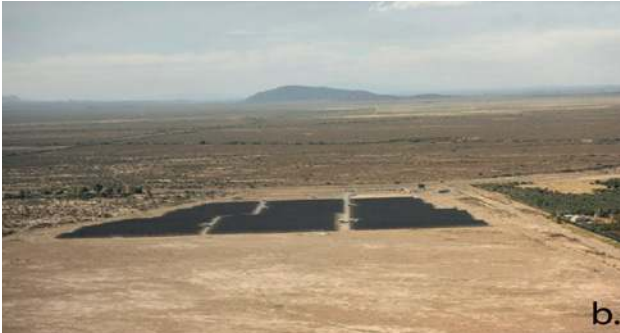
Imagen 1b – Central fotovoltaica Cañada Honda (San Juan).
